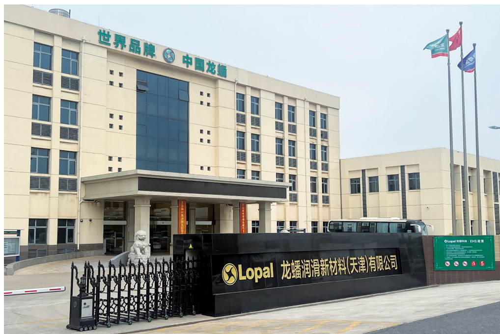
Корпус управления заводом Lopal
